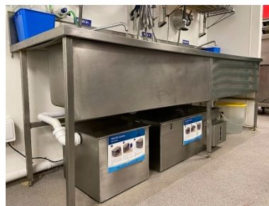
Séparateur de graisses FiltaFOG Cyclone combiné avec un autre équipement
