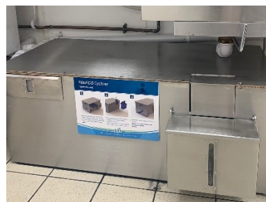
Séparateur de graisses FiltaFOG Cyclone
