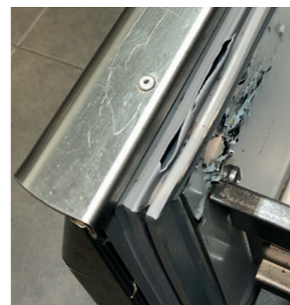
joint de porte usé
